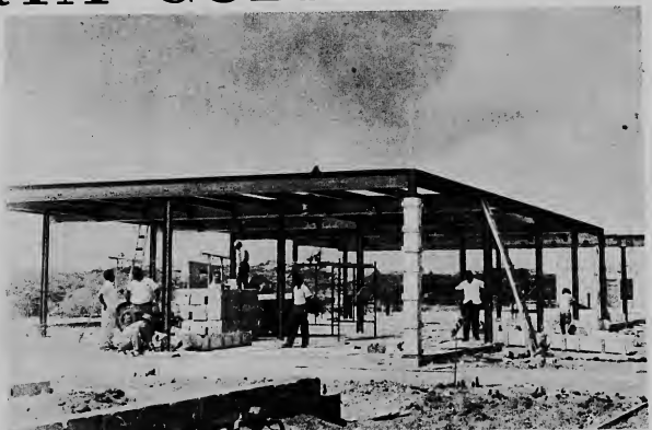
E edificio nobo di ELMAR cu ta worde construi den Wilhelminastraat na Oranjestad, poco poco ta cuminsa hanja su forma. Den e dianan aki e trahadonan di CARIBBEAN CONTRACTORS COMPANY, e empresa cu ta construi e edificio a pone e "skeleton" pa e edificio. E foto ta muestra e skelèt di e parti di e edificio cu lo worde usa pa oficina. Pa mas o menos october di otro aña Caribbean Contractors ta sera na entrega e edificio completamente cla na ELMAR.
